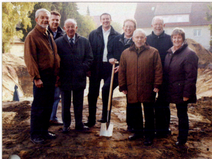
„Der symbolische erste Spatenstich für den nichtunterkellerten Teil,“ lacht Oliver Balzar (Mitte) – mit ihm freuen sich über den Baubeginn (v.l.) Götz Balzar, Frank Meise, Fritz Weßling, Ingo Hansen, Werner Krauss, Friedrich-Karl Völkner und Margret Hanke.
