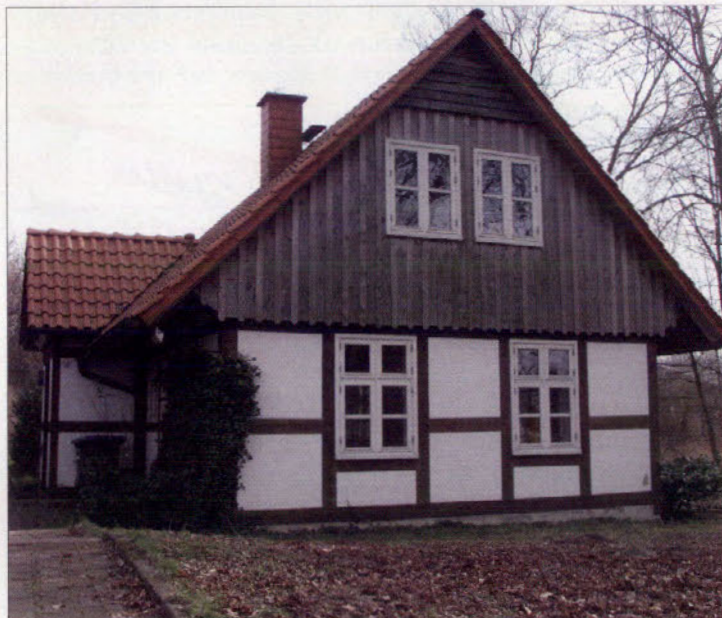
Hier lässt es sich gut arbeiten: die Firma Michaelis ist jetzt im Fasanenweg 15 ansässig
