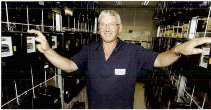
In Günther Christens Zählerlager bei der TWO liegen Hunderte geeichter Stromzähler bereit, um in den Haller Haushalten ausgetauscht zu werden.
