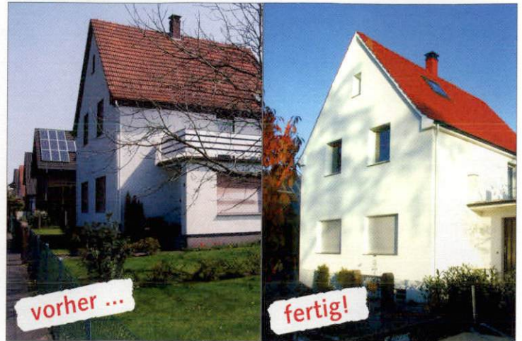
Die Dachbeschichtung ist eine kostengünstige Alternative zur Neueindeckung
