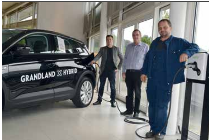
Claus Möller, Michael Wiehlmann und Bernd Gerling (v.l.) sind zufrieden: die drei neuen Ladesäulen für Elektrofahrzeuge können an den Start gehen
