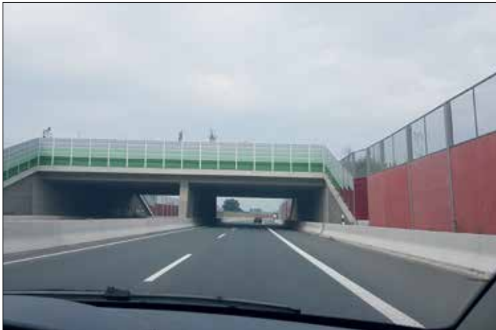
Eine der Grünbrücken auf dem neuen Autobahnabschnitt zwischen Halle und Borgholzhausen.
