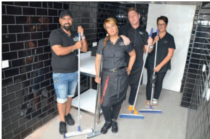
Bis zur Eröffnung gibt es noch viel zu tun für Erdal Sis, Ria Moschido, Marciej Nawicki und Samantha Collins (v.l.), denn noch ist die zukünftige Grill-Lounge mehr Baustelle als Küche
