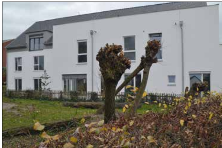
Das großzügige Gebäude bietet Platz für eine betreute Wohngemeinschaft im Erdgeschoss, für eine Tagespflegeeinrichtung in der ersten Etage sowie für fünf seniorenerechte Wohnungen im zweiten OG
