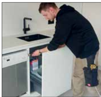
Jan-Hendrik Wiedey, Küchenmonteur in der Ausbildung, bei der Installation einer Rotpunkt-Küche bei Kundschaft in Münster
