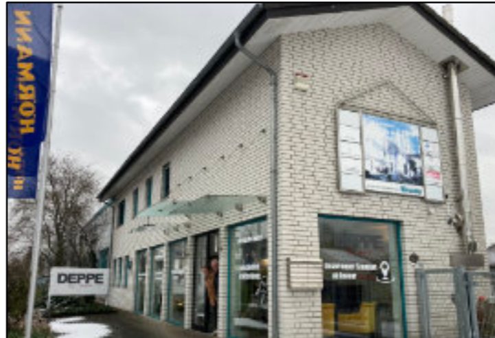
Das neue Firmengebäude der Firma Deppe Tore GmbH bietet durch den direkt am Gartnischen Weg liegenden Standort eine sichtbarere Präsenz
