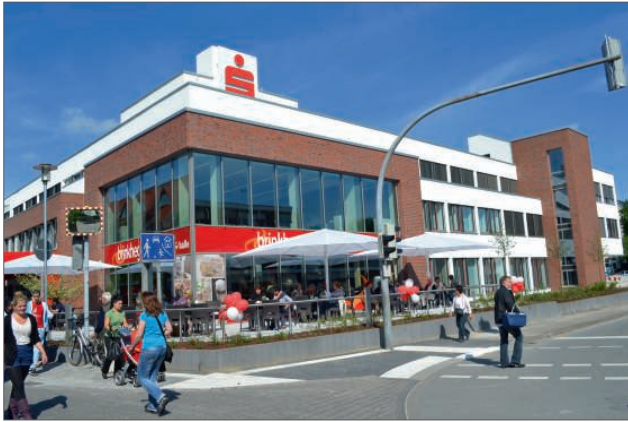
Die Kreissparkasse Halle hat ein neues Outfit bekommen. Im Rahmen einer kleinen Feierstunde ist die neu gestaltete Zentrale offiziell ihrer Bestimmung übergeben worden. Die Kosten des Umbaus betragen rund 8,1 Millionen Euro.
